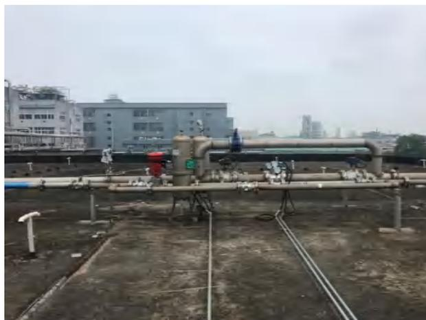
案例 3：制氮系统安装消声器，减小噪声
